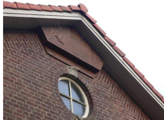
kast op huis/schuur buiten
