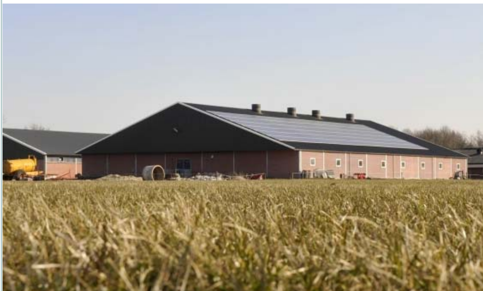
Varkensstal met zonnecollectoren
